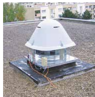
Extracteur mécanique
